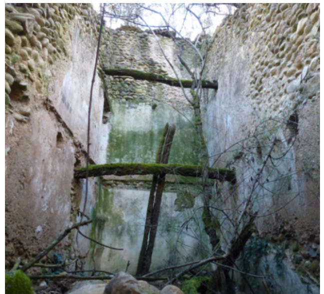
L'intérieur laisse apercevoir aujourd'hui encore une construction sur trois niveaux.
