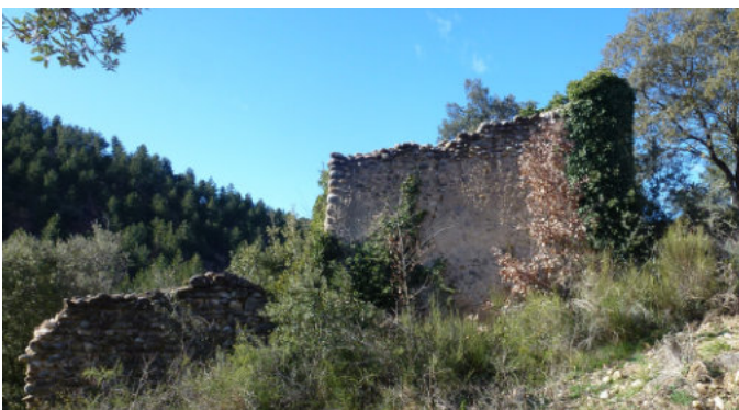
Voici la ruine de la rive gauche du vallon.
