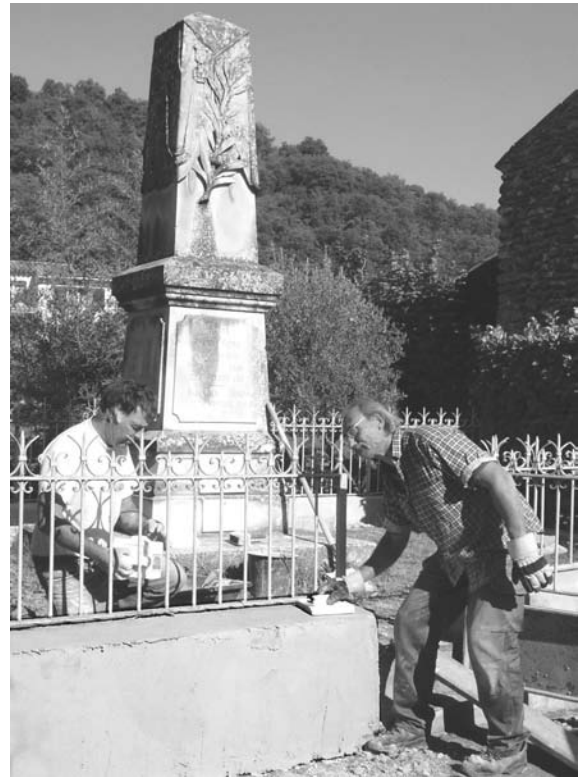
Jeannot Puig et Yves Crète, de l'association ERA, pendant les travaux de rénovation.
