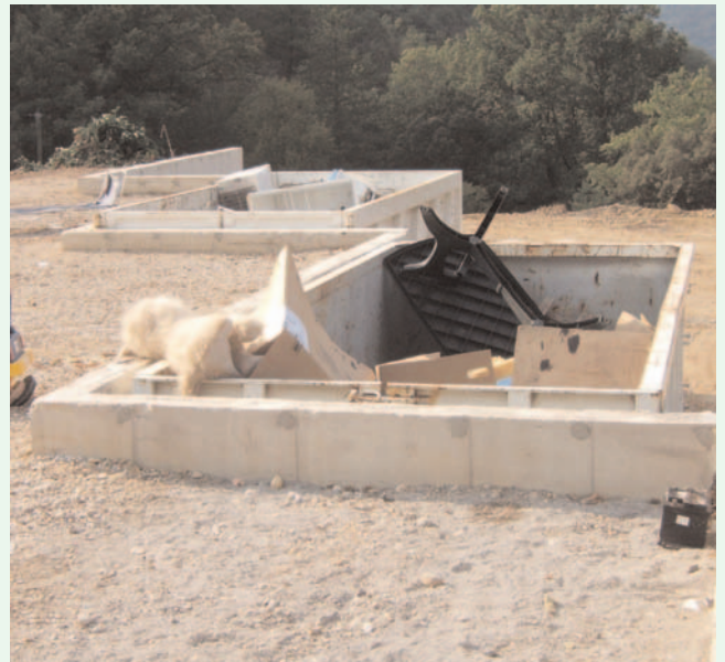
La déchèterie de la Communauté de communes du Val de Rancure se trouve sur la commune du Castellet. Elle vient d'être mise aux dernières normes.
