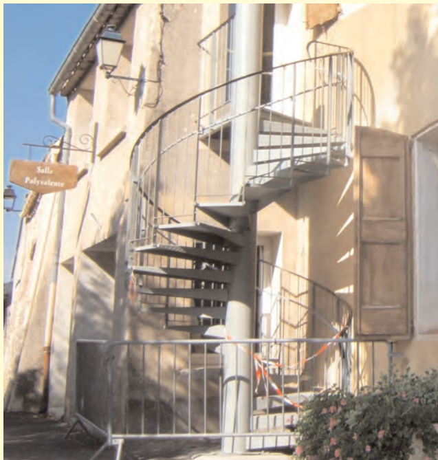
Ce nouvel escalier est l'issue de secours de l'école maternelle.
