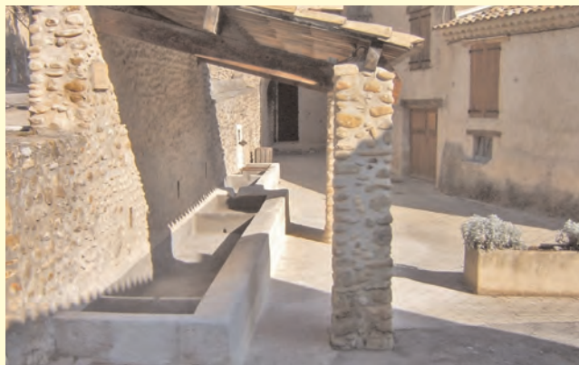
En 2009 le lavoir du Pountis a été entièrement rénové.
