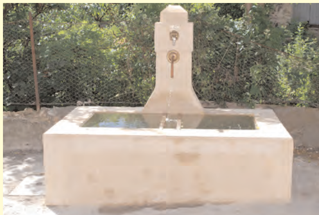
La fontaine de la place de la mairie a été dotée d'un circuit d'économie d'eau.
