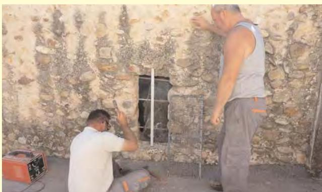
*Travaux de pose d'une grille devant une ouverture dans un mur de la cour de l'école pour la sécurité.*
