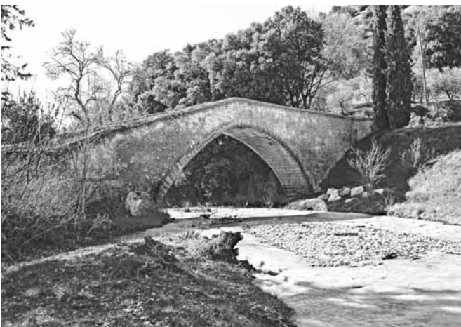
Le pont roman d'Oraison est le premier ouvrage d'art lancé au-dessus de Rancure en 1698.
