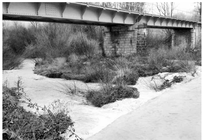
Au début du XX e siècle les ponts ont été des ouvrages métalliques supportés par des piles de béton armé.
