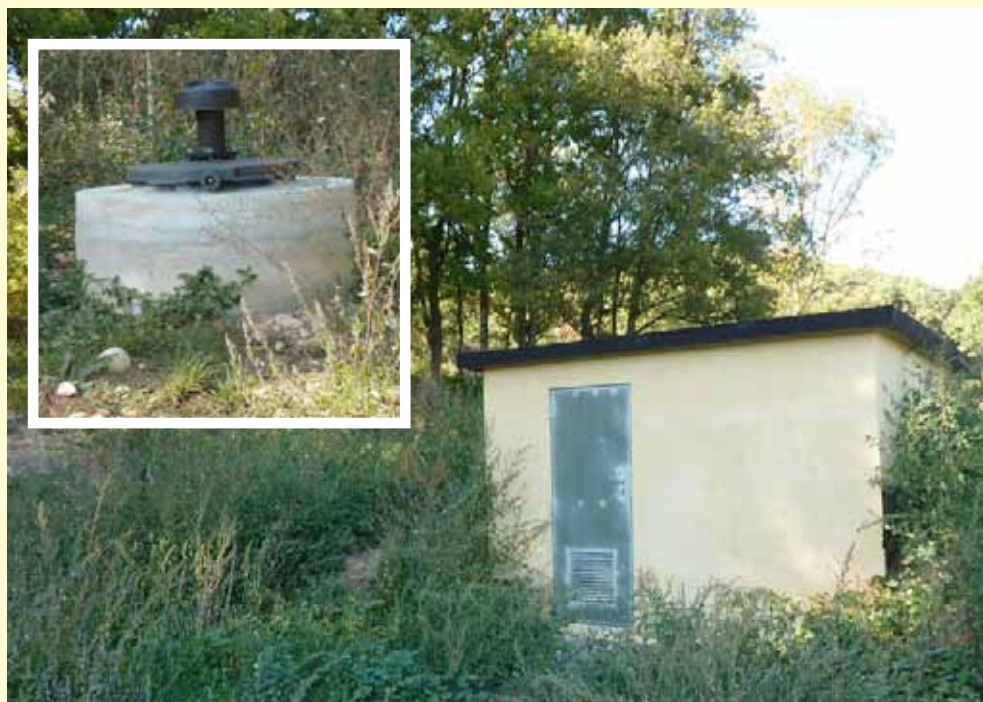
Le captage et le bassin tampon actuels de la source de Laga serviront également dans l'avenir à l'alimentation d'Entrevennes et de Puimichel.
