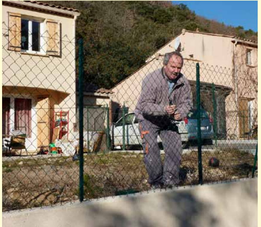
Patrick Roche fixe le grillage aux poteaux préalablement scellés.
